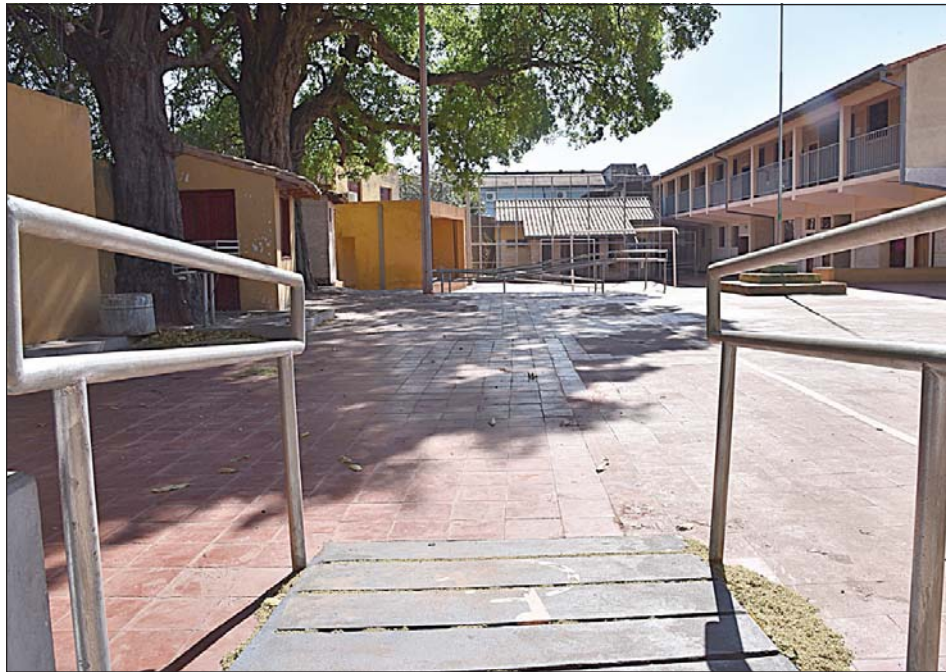
¿Inclusión? Un acceso para alumnos con discapacidad construido en una escuela pública.
